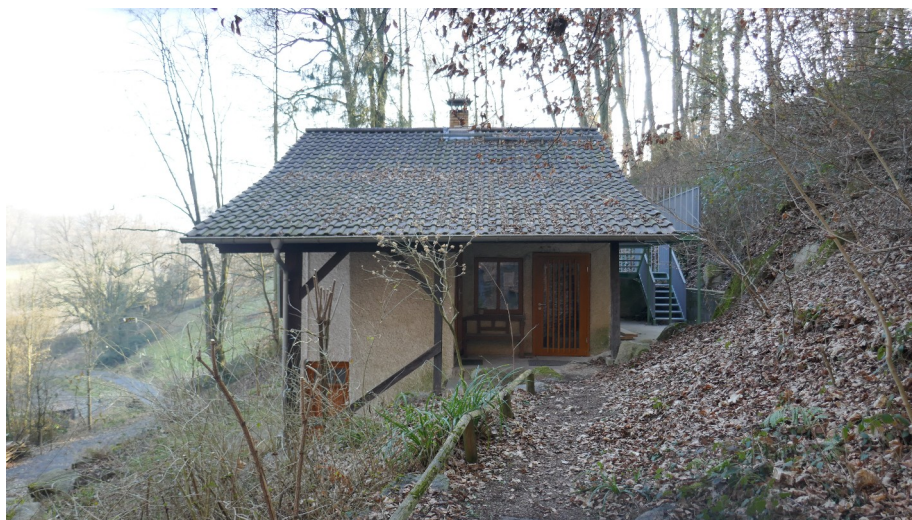
Die Hütte von Norden nach dem Umbau. Rechts die neue Fluchttreppe.
